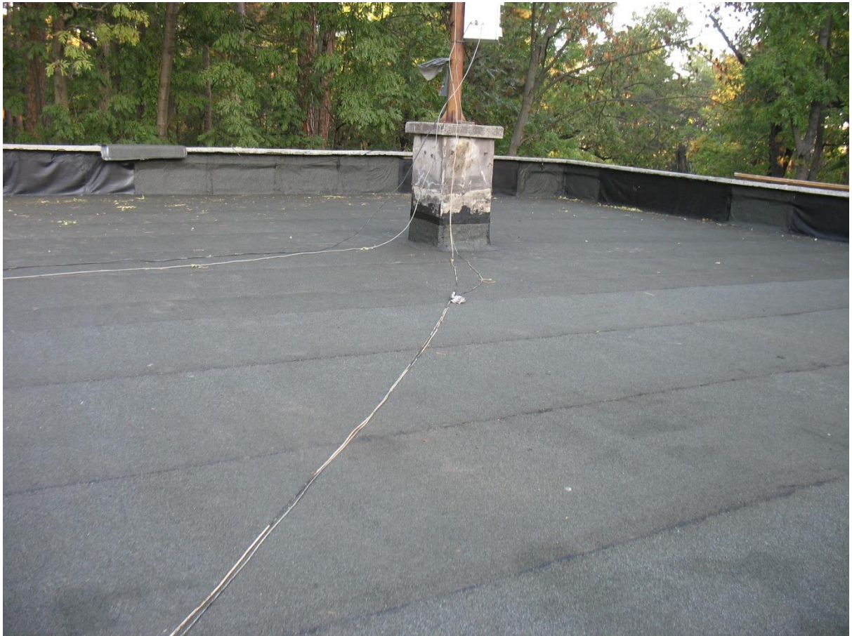
Снимка 2. Битумната хидроизолация, нанесена до горния вътрешен ръб на парапета.
