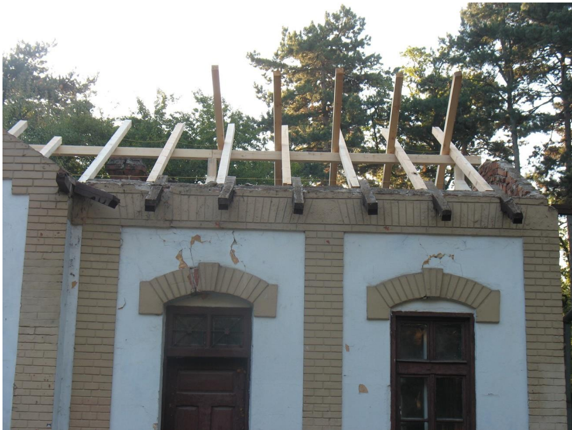
Снимка 4. Покривните ребра – отрязаните външни части на старите са съединени с новите с пирони.
