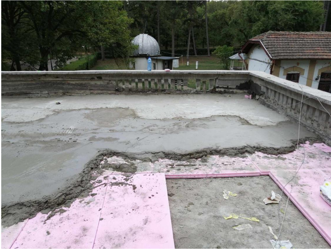
Снимка 1. Слой фибран (4 см) и замазка върху покрива на Административната сграда.
