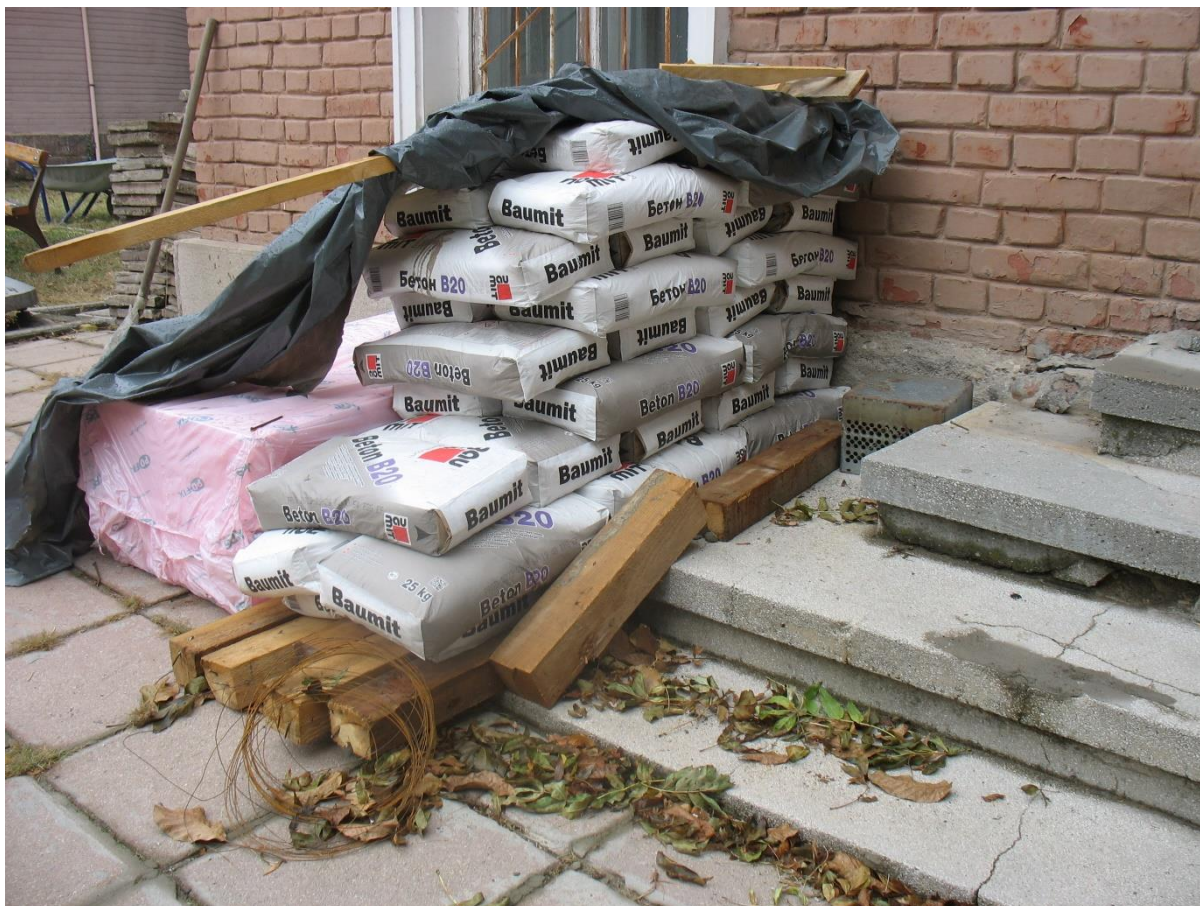
Снимка 10. Една малка част от оставения на въздействието на влагата строителен материал.
