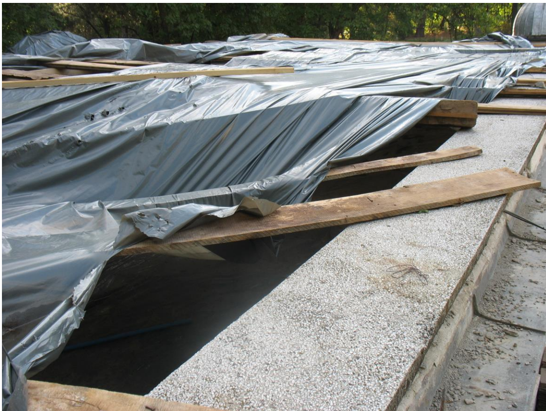
Снимка 4. Найлонът върху конструкцията бе разпокъсан часове след слагането му.
