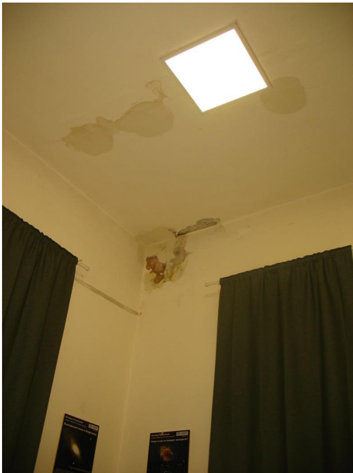
Снимка 6. Мокър таван ъгъл с паднала мазилка в помещението с блинк-компаратора.
