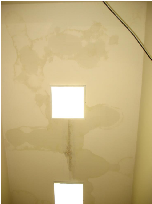
Снимка 8. Тавана на коридора. Малко след снимката, led-панелите, пълни с вода, спряха да светят.
