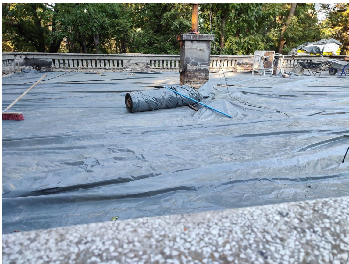
Снимка 2. Постлан найлон – ролка със ширина 2 м. на дъното на така полученото се корито на покрива.
