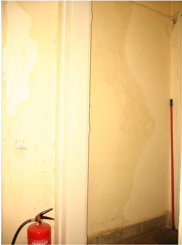
Снимка 5. Мокра мухлясала и олюпена стена в коридора.
