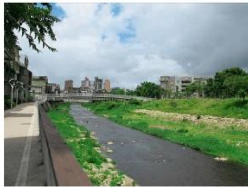
Фигура 4. Напречено сечение на възстановен участък с един „твърд“ и един „мек“ бряг (Laojie River, Taoyuan по Rung-Jiun Chou, 2016 )
